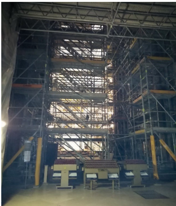
Interior da catedral de Compostela em restauração
